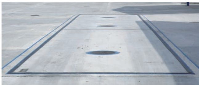
Obr. 44 Zapustená cestná mostová váha
